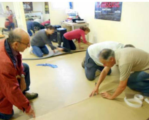
Chantiers 8 : réparation du sol de la salle de danse
